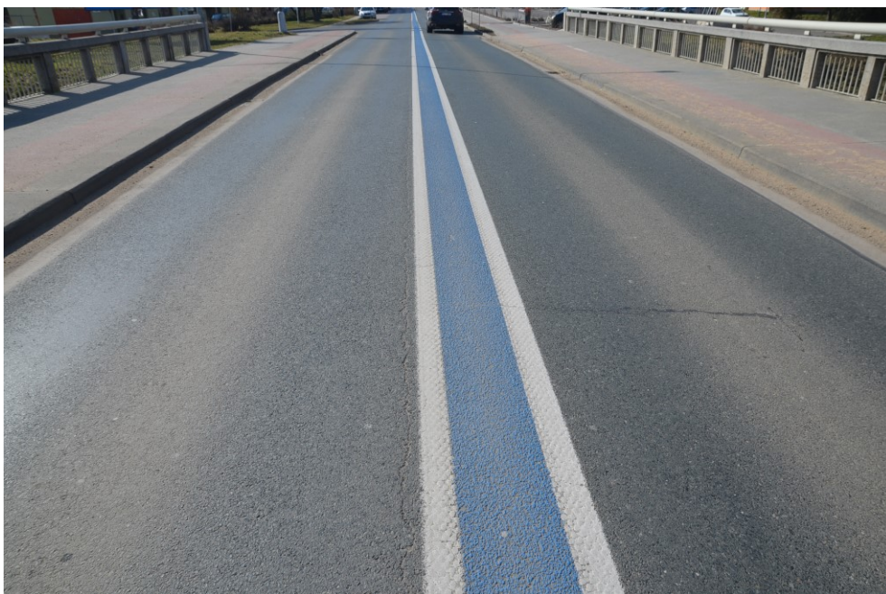
Obr.G19-04 Vozovka na třetím poli mostu. Pohled ve směru staničení, od Židlochovic ke Znojmu a dolů, - pracovní spáry a trhliny ve vozovce třetího pole nebyly po havárii zality zálivkou z modifikovaného asfaltu.
