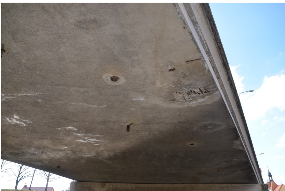
Obr.G19-24 Podhled nosné konstrukce ve druhém poli. Pohled zprava doleva (po vodě), ve směru staničení a vzhůru, - rozsáhlé stopy po zamáčení podhledu nosné konstrukce.
