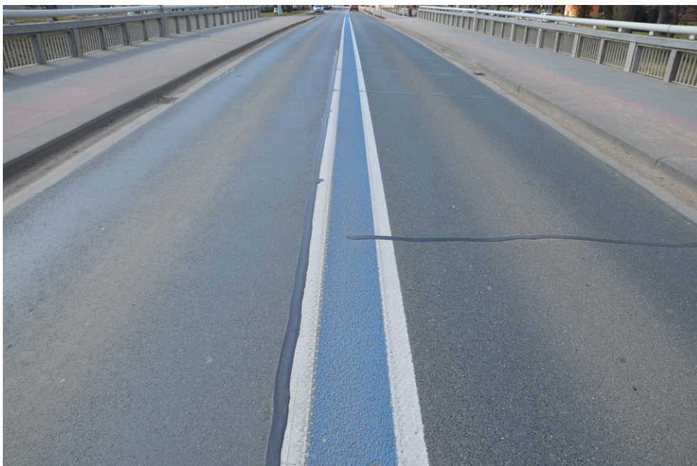
Obr.G19-03 Vozovka na druhém poli mostu. Pohled ve směru staničení, od Židlochovic ke Znojmu a dolů, - pracovní spáry a trhliny ve vozovce druhého pole byly po havárii zality zálivkou z modifikovaného asfaltu.
