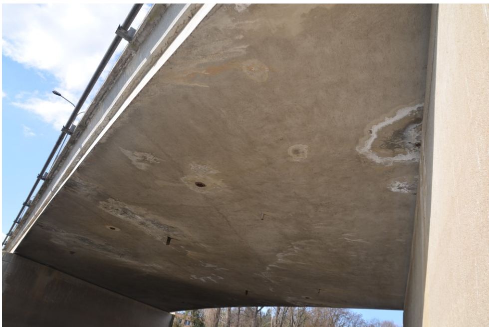
Obr.G19-23 Podhled nosné konstrukce ve druhém poli. Pohled ve směru staničení, zleva doprava (proti vodě) a vzhůru, - rozsáhlé stopy po zamáčení podhledu nosné konstrukce.
