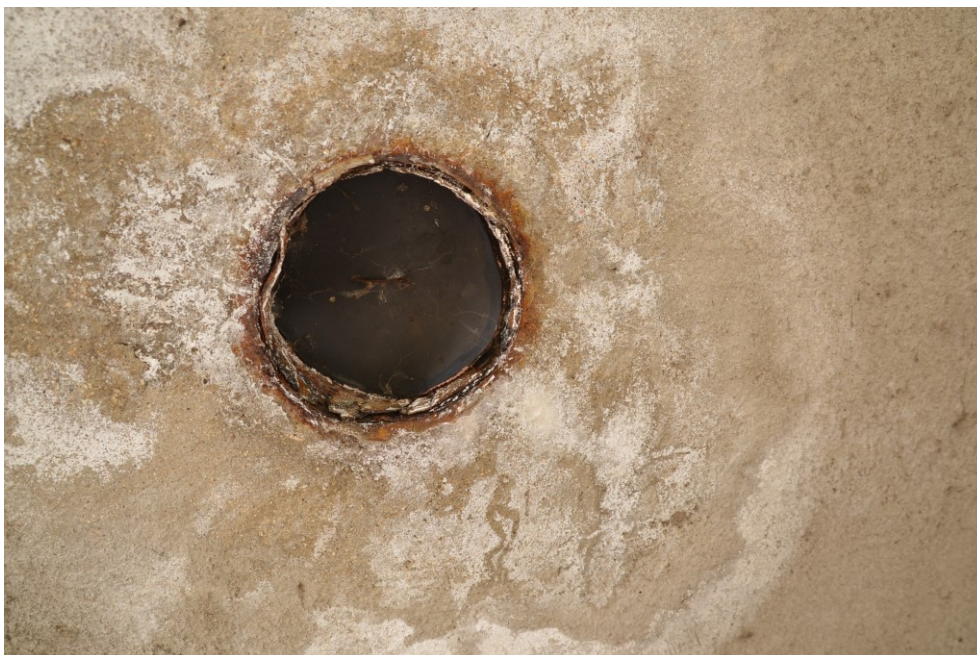
Obr.G19-15 Detail utěsnění odpadní trouby původního levostranného mostního odvodňovače na začátku prvního mostního pole. Pohled vzhůru.
