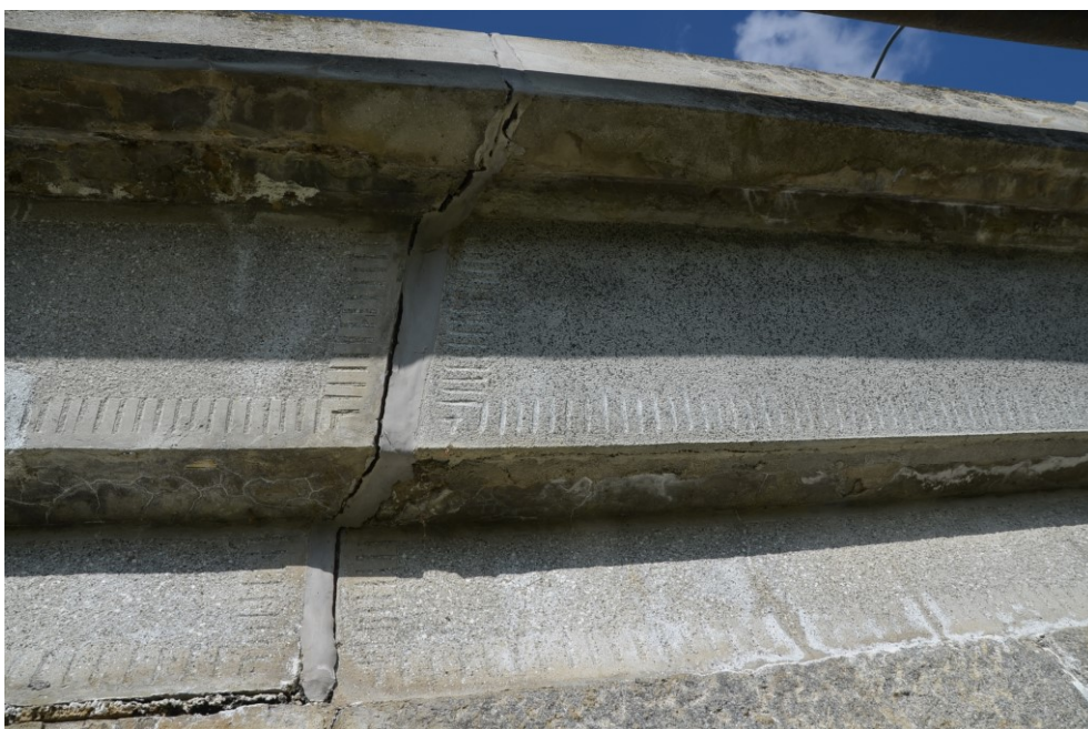
Obr.G19-05 Závěrná zeď první podpěry, židlochovické opěry (vpravo) a začátek nosné konstrukce (vlevo). Pohled zleva doprava (proti vodě),
