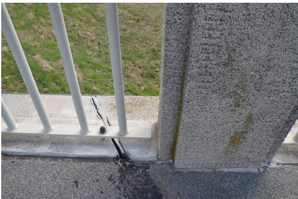
Obr.G19-06 Temeno levostranné římsy nad závěrnou zdí první podpěry, židlochovické opěry (vlevo) a nad začátkem nosné konstrukce (vpravo). Pohled zprava doleva (po vodě) a dolů,
